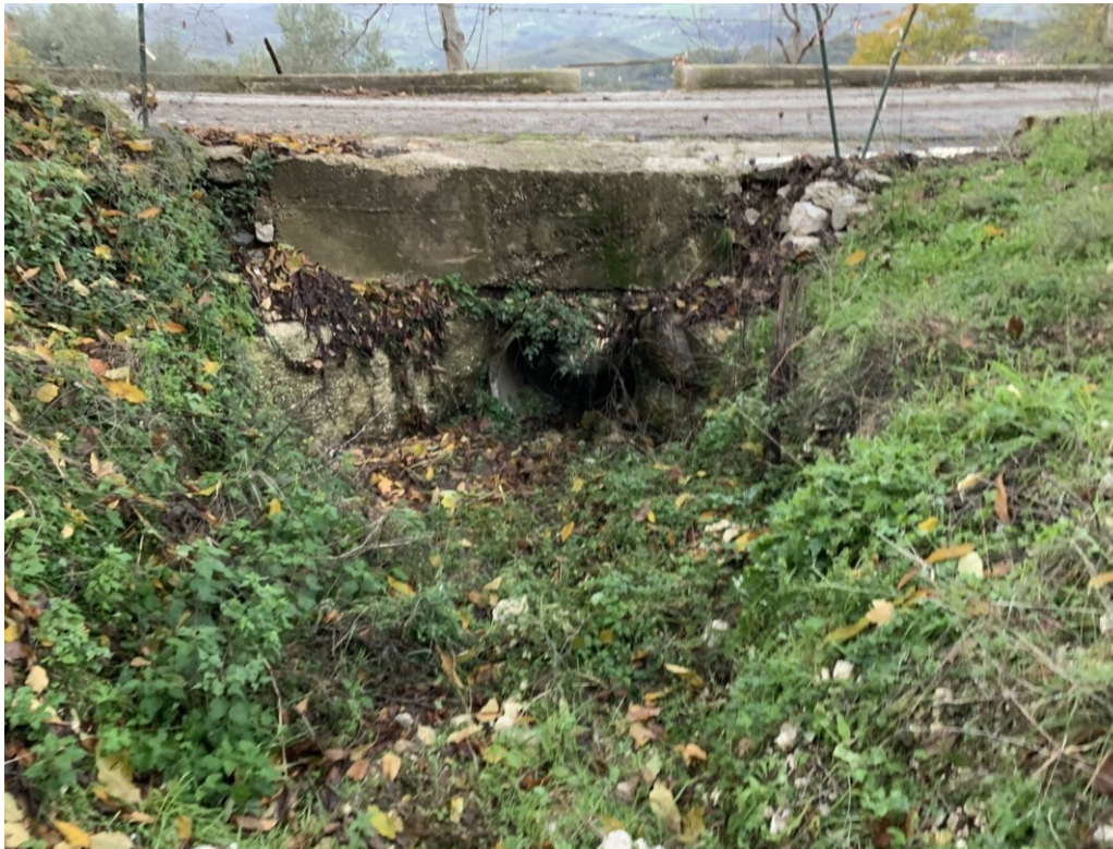
Foto n.5 - Vista da monte attraversamento
