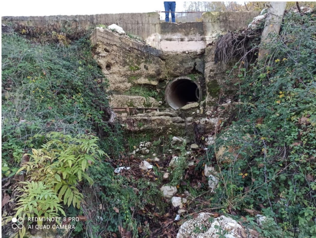
Foto n.4 - Vista da valle attraversamento
