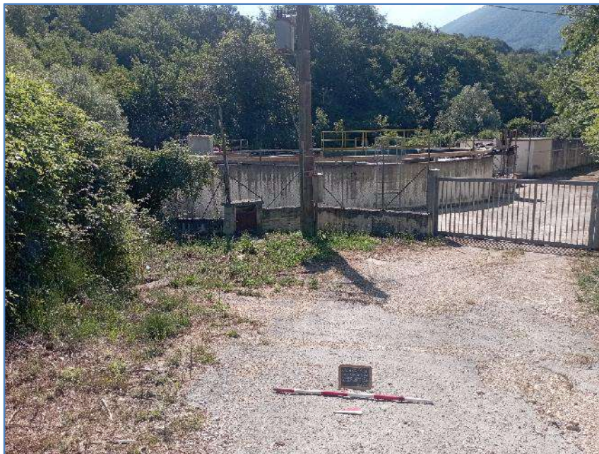
Foto n. 3: vallone Carassato, settore N, particolare dell'area recintata del potabilizzatore
