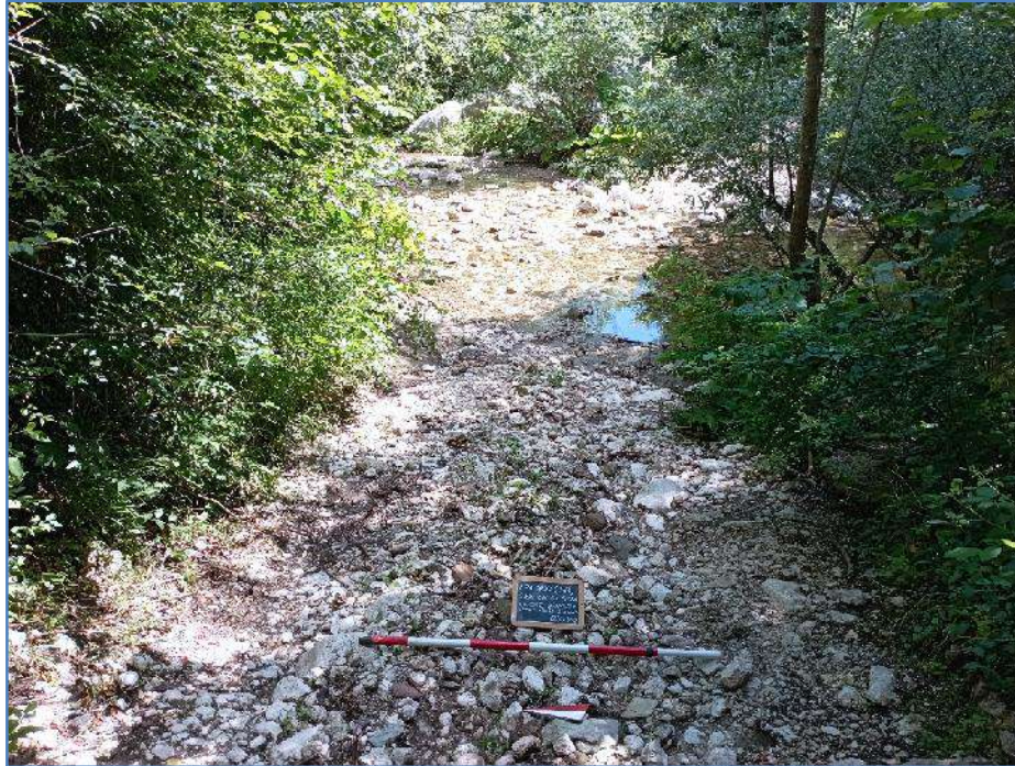
Foto n. 7: vallone Carassato, settore S, stato dei luoghi a ridosso del ponte San Donato
