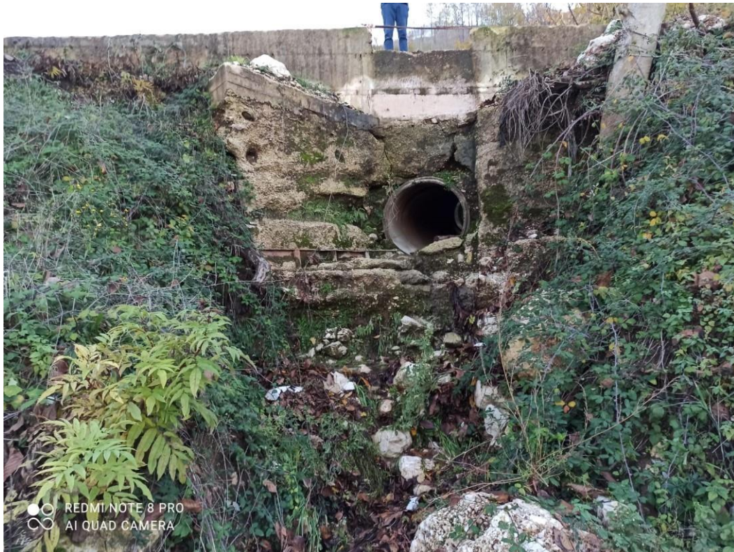
Foto n.4 - Vista da valle attraversamento
