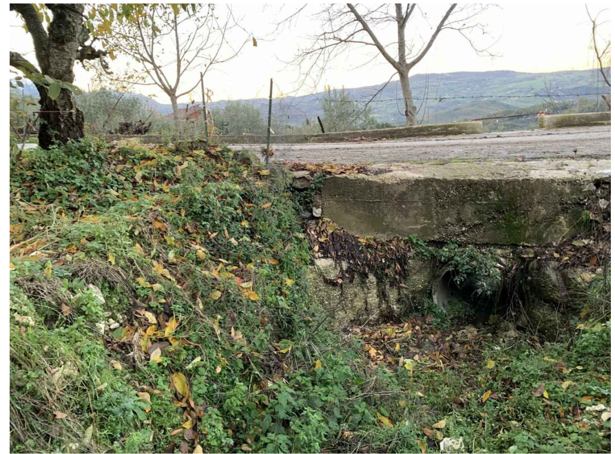
Foto stato di fatto Tratto 3
