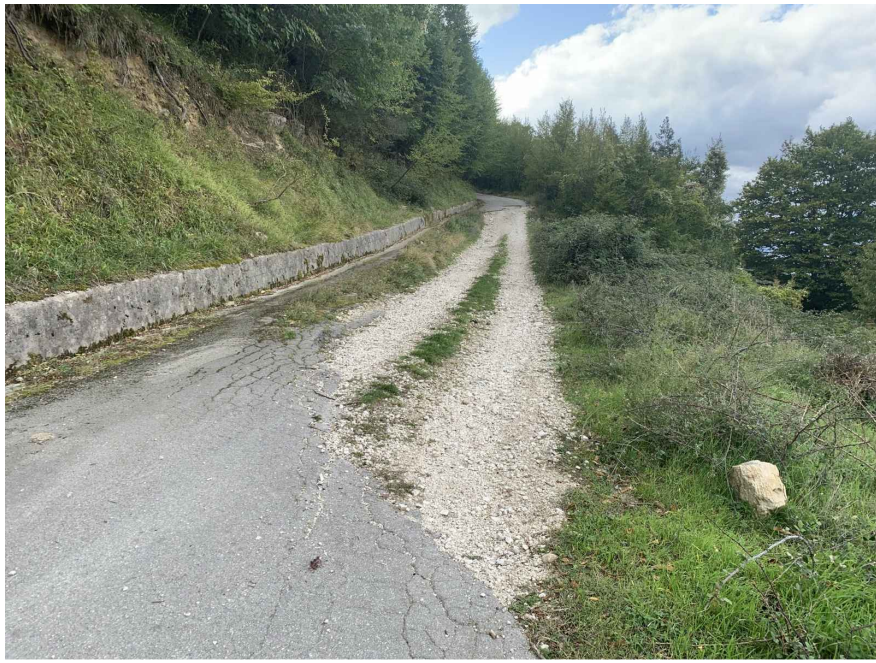
Foto stato di fatto Tratto 4
