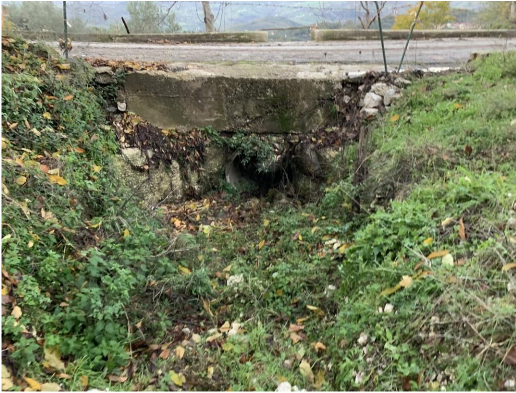
Foto n.5 - Vista da monte attraversamento
